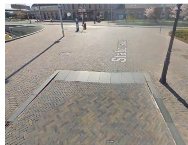
Omzetten van de natuursteen band op aanliggende straten
